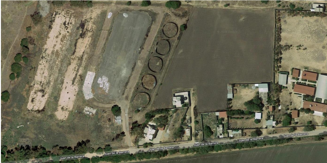
Imagen 12. Vista superior de los restos de silos en el Ahorcado.
