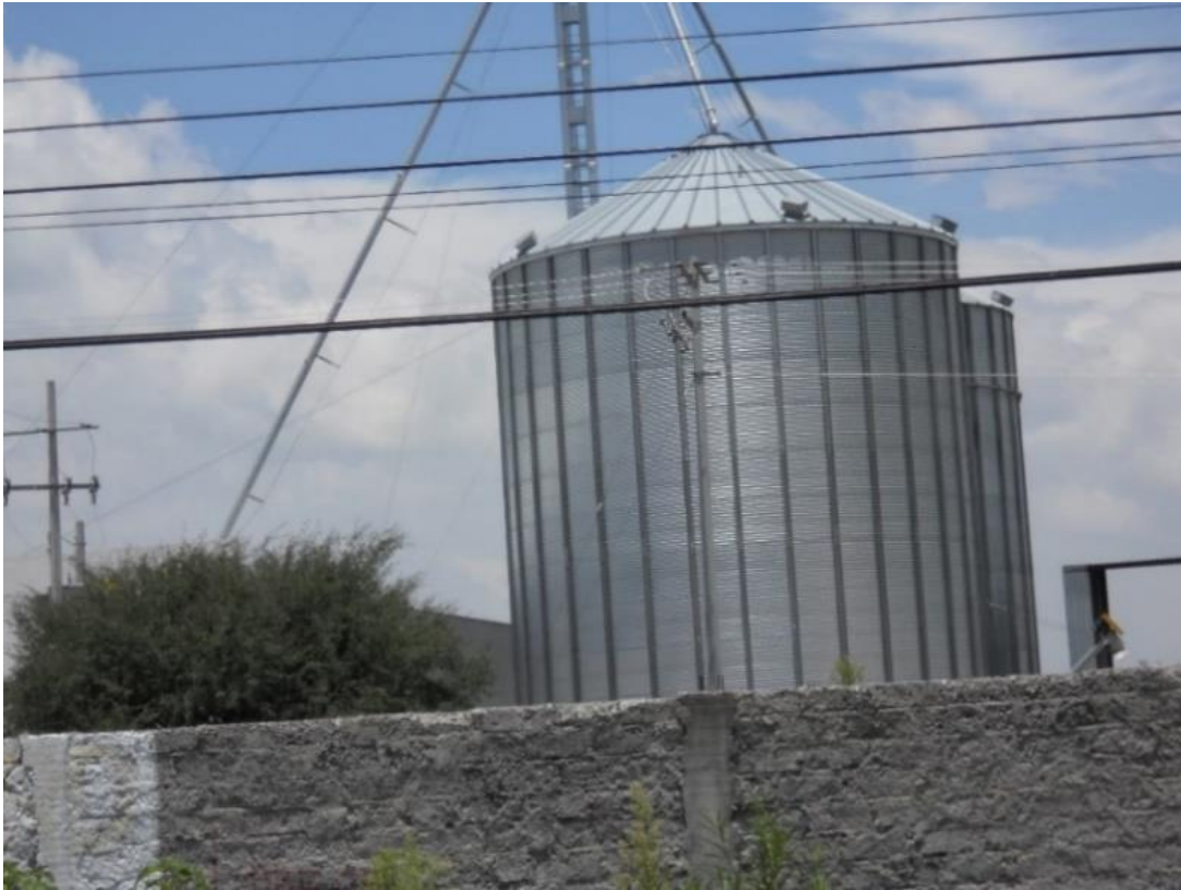
Imagen 24. Silos de almacenaje de Finca Agrarista-Módulo 2.
